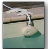
Système de régulation du niveau d'eau
