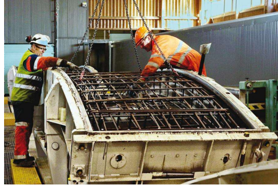
Fig. 9 Armature du voussoir dans le moule avant la coulée
