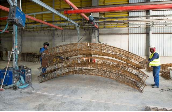
Fig. 8 Structure métallique de voussoirs
